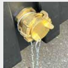
Hauptwasseranschluss mit GEKA-Kupplung
