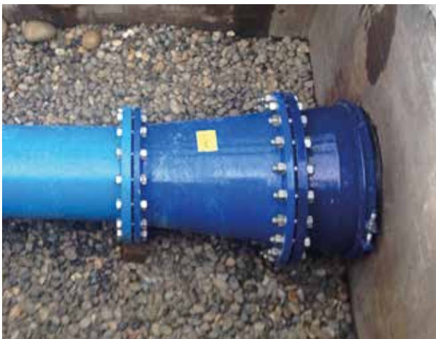
Einbau Hymax® Flansch DN 500.
