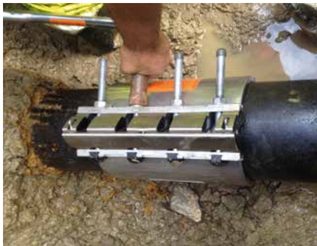
Reparatur einer Gussleitung mit RepaFlex® 22.
