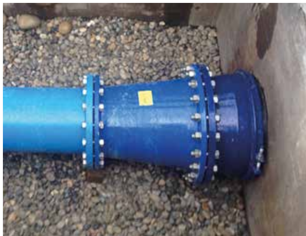
Montage d'une Hymax® bride DN 500.
