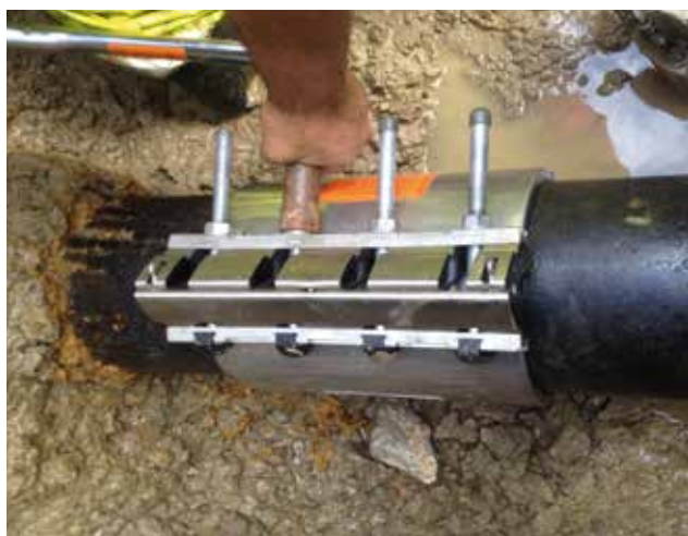
Réparation d'un tuyau en fonte avec RepaFlex® 22..
